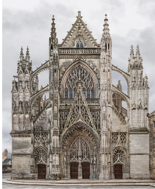
Figure 2.80: Architectural detail (Vendôme, Eglise de la Trinité)
